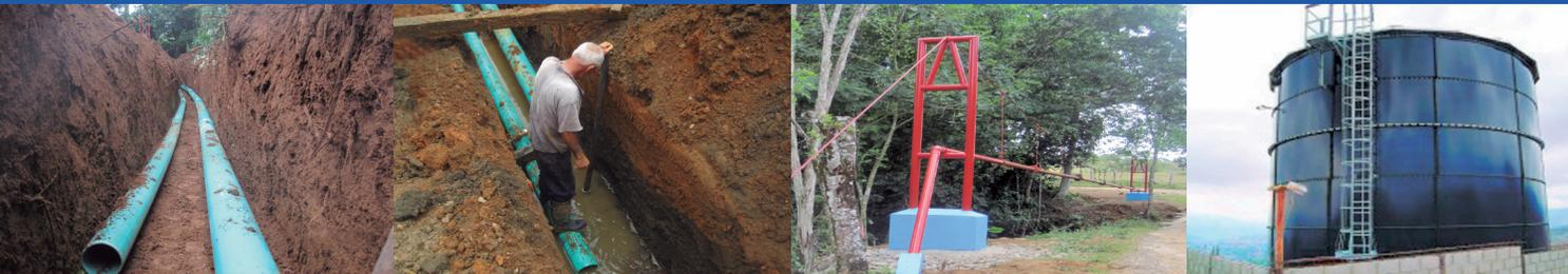
**1** Construcción de la red de tuberías de distribución
